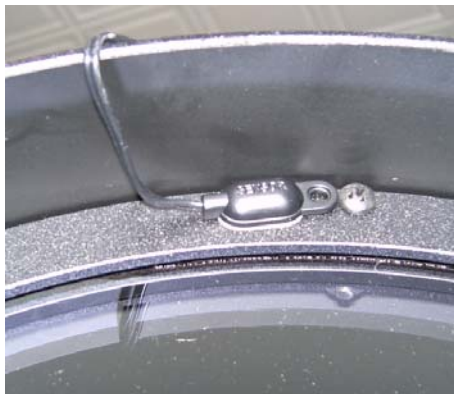
Sensor an Schmittplatte montiert
