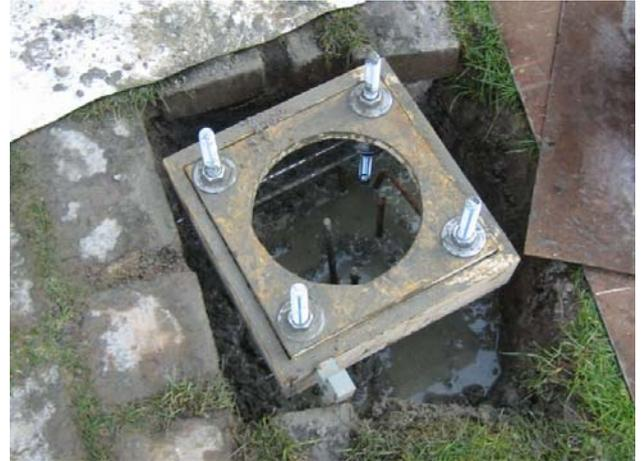
Schließlich wurden Rasengittersteine zugeschnitten und eingesetzt. Außerdem wurde die ausgeschnittene Holzplatte wieder in den Deckel eingesetzt. Nun sieht die „Baustelle schon wieder recht aufgeräumt aus und der Beton kann austrocknen. Erst danach wird dann die Holzdeckelplatte und der sie umgebende Rahmen entfernt. Die Gewindestangen werden erst gekürzt, wenn der gesamte Aufbau den ersten Probetrieb bestanden hat.
