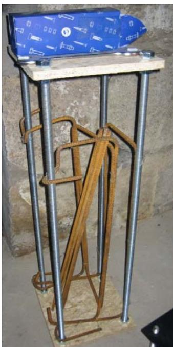
Die Bodenplatte der PierTech Säule wird durch 4 Stück M28 Gewindestangen der Länge 100cm im Boden verankert. Um während des Betonierens für eine optimale Ausrichtung zu sorgen wurden die 4 Gewindestangen mittels zweier Holzplatten fixiert. Die untere Platte verbleibt im Boden, die obere Platte wird nach dem Austrocknen des Betons entfernt und durch eine massive Alubodenplatte ersetzt. Das Gerüst wurde noch durch einige Armierungsstäbe aus Eisen verstärkt.
