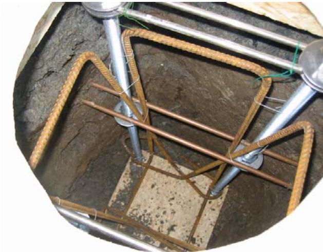
Ein Blick durch die Deckelplatte in das noch ungefüllte Loch zeigt die Bodenplatte sowie die zahlreichen Armierungseisen, die mit den Gewindestangen verbunden sind und das Fundament versteifen sollen.
